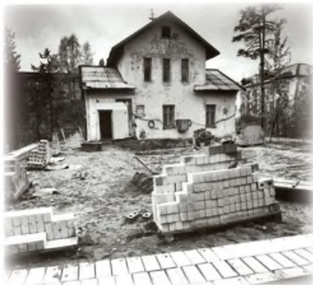
Строительство районного краеведческого музея
