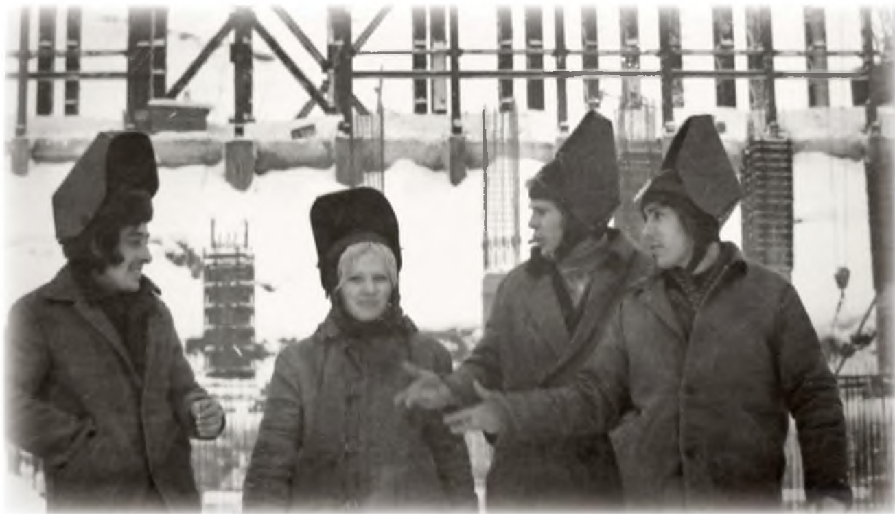
Строится главный корпус АБОФ
