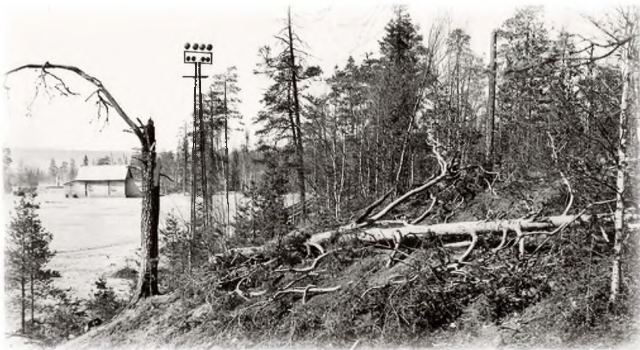
Так начиналось строительство стадиона. 1971 г.
