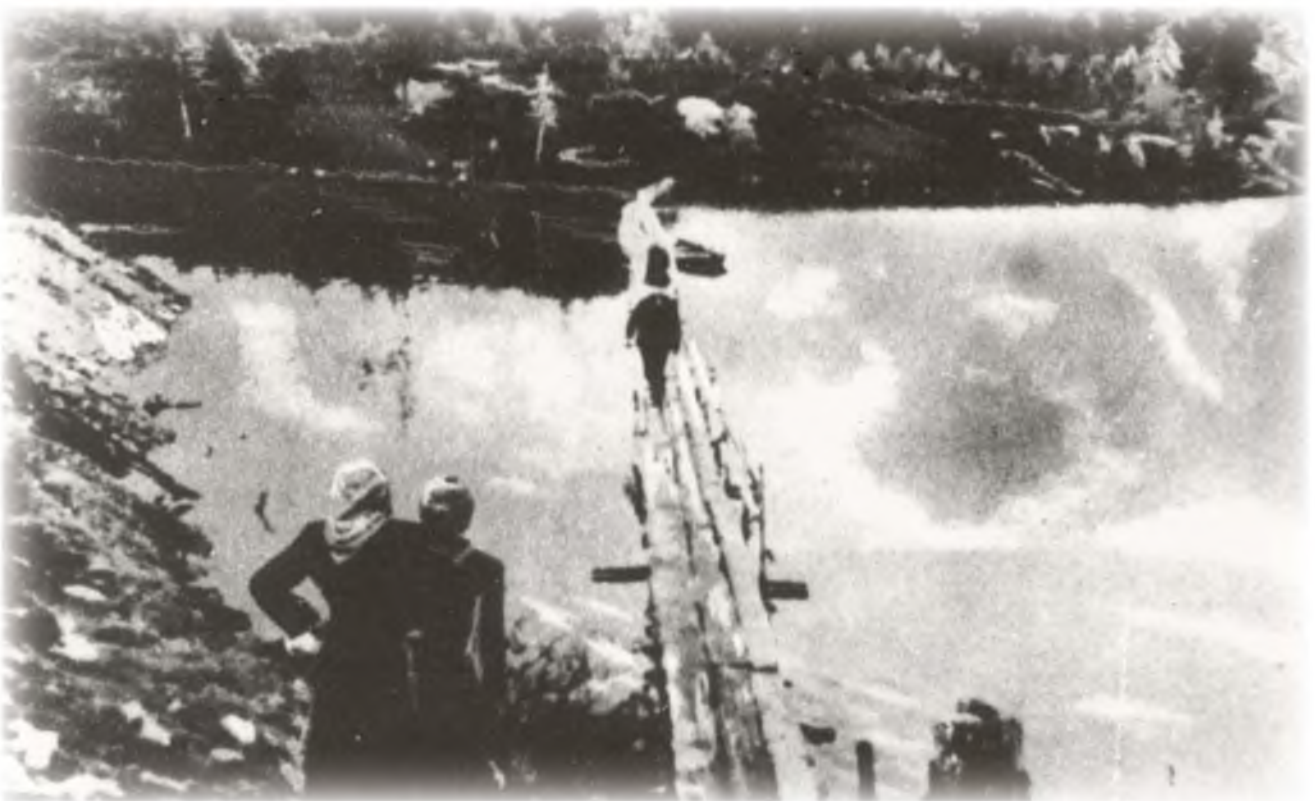
Деревянный мостик через озеро Ковдоре
