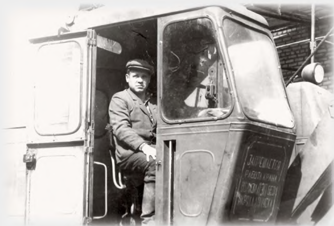
Головкин Б. Н. на строительстве спорткомплекса
