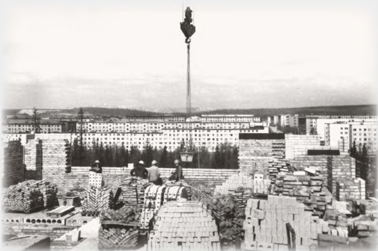
Строительство жилого дома по улице Кошица
