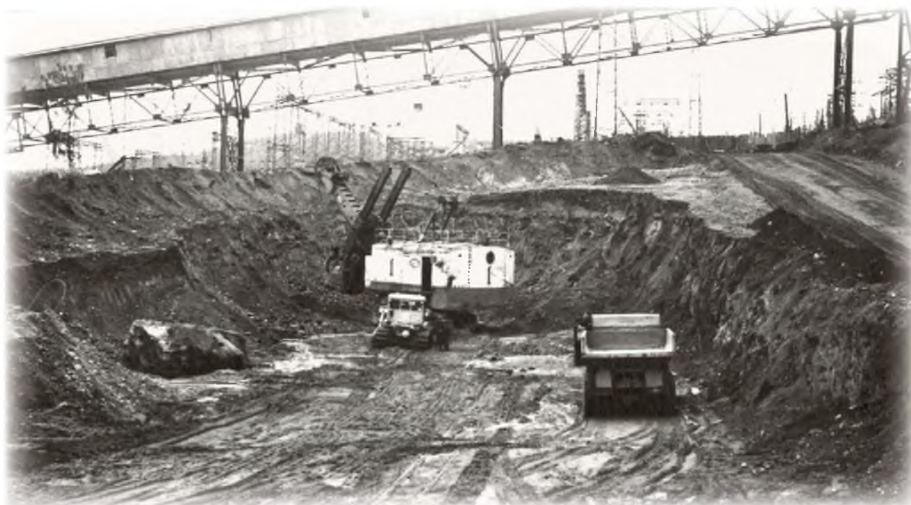
Котлован под застройку АБОФ
