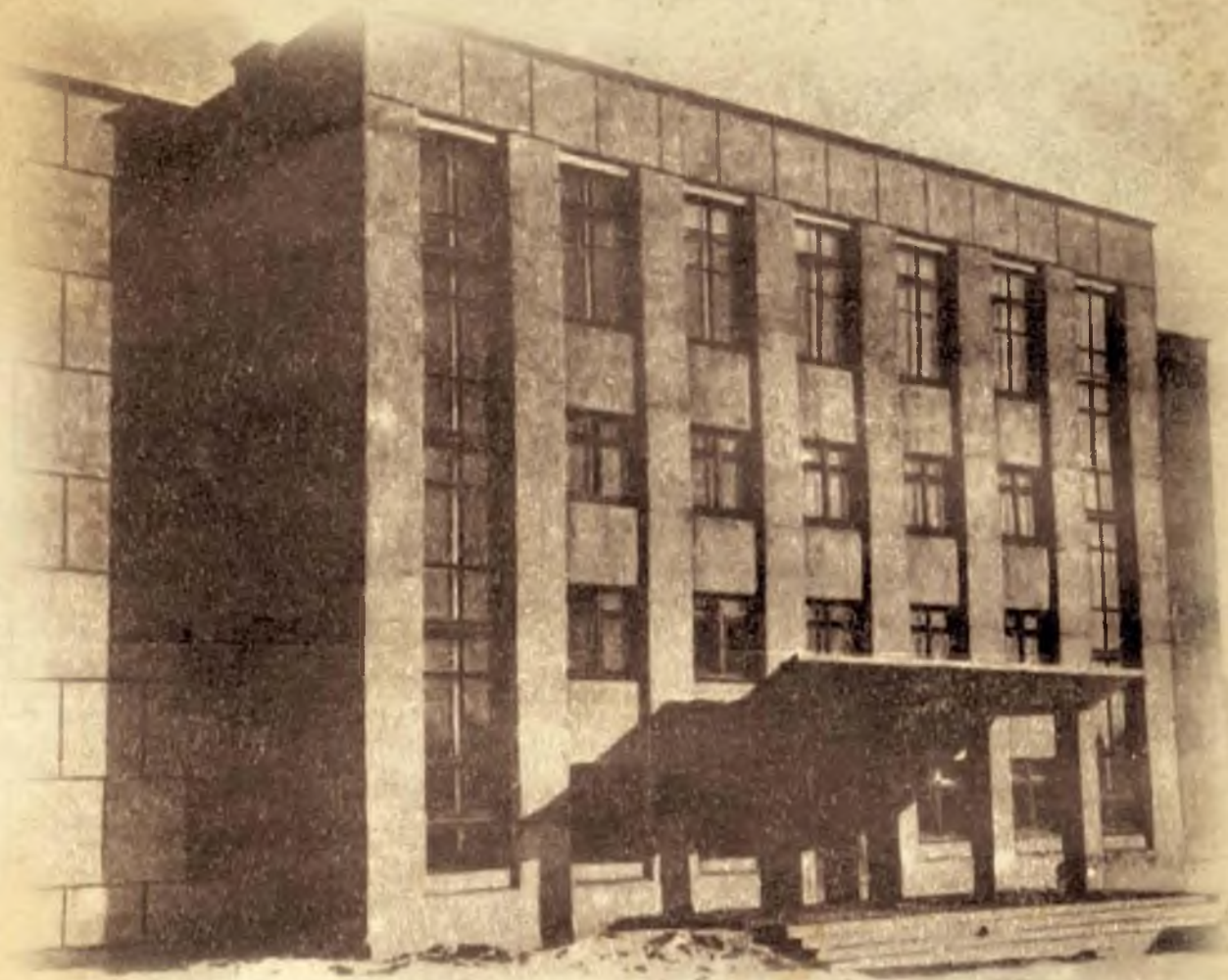
Здание управления треста «Ковдорстрой»
