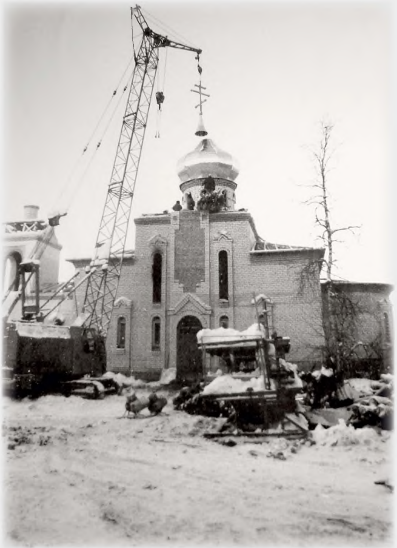
Строительство Свято-Успенского Храма в Ковдоре
