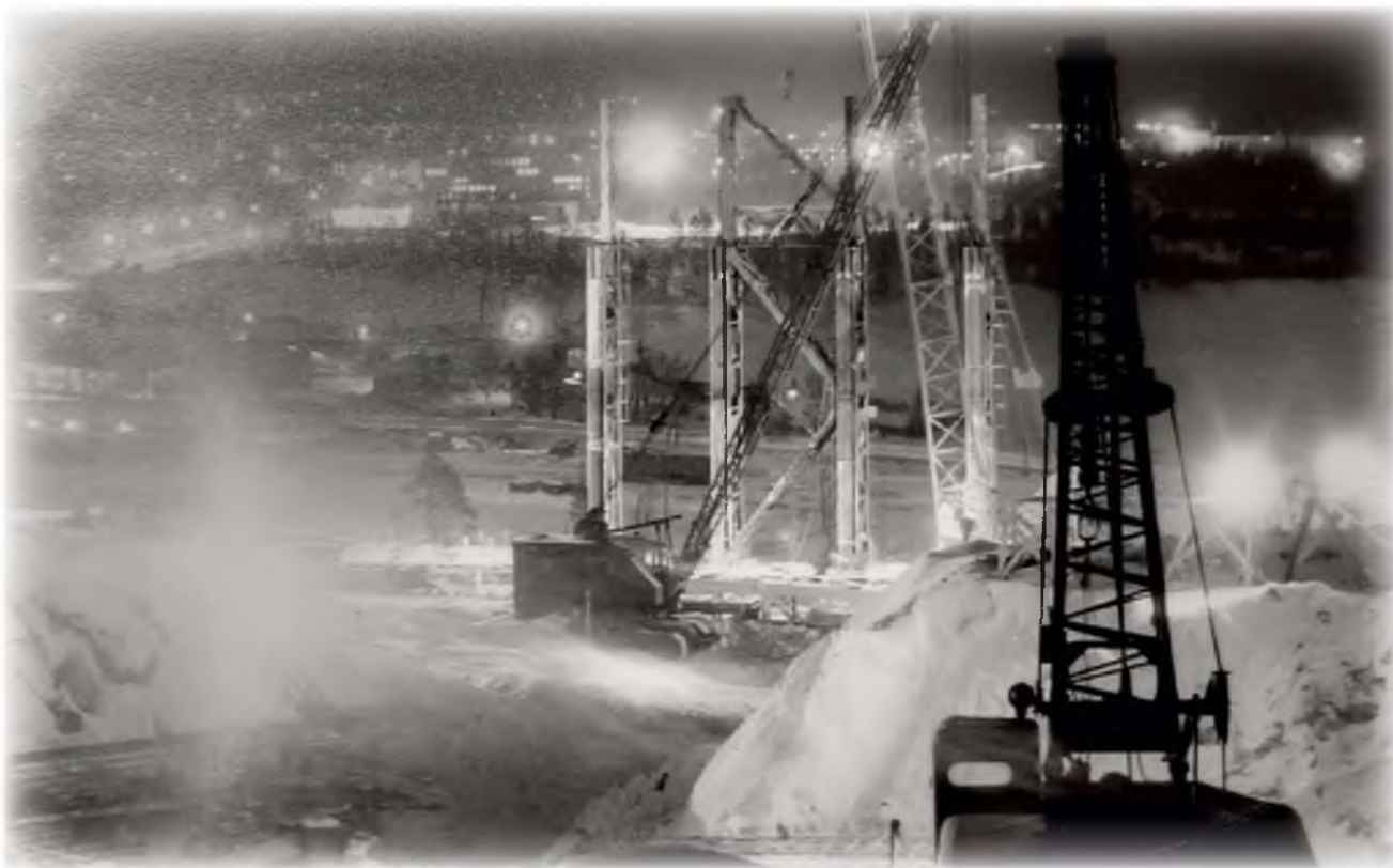
Строительство АБОФ. Корпус обогащения. Январь 1974 г.
