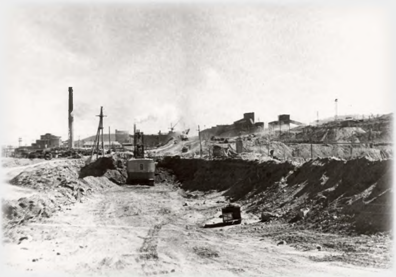
Начало строительства АБОФ
