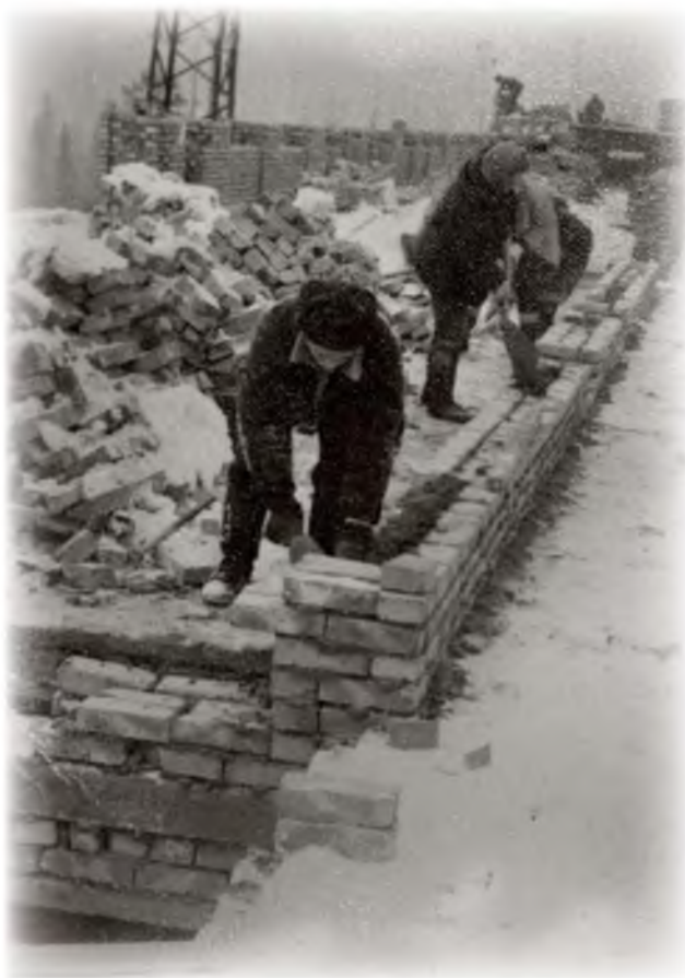
Кирпичи укладывали вручную...
