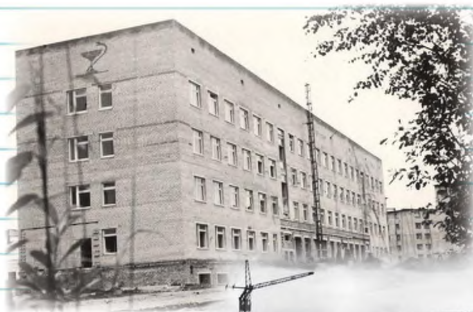
Строится городская поликлиника. 1978 г.
