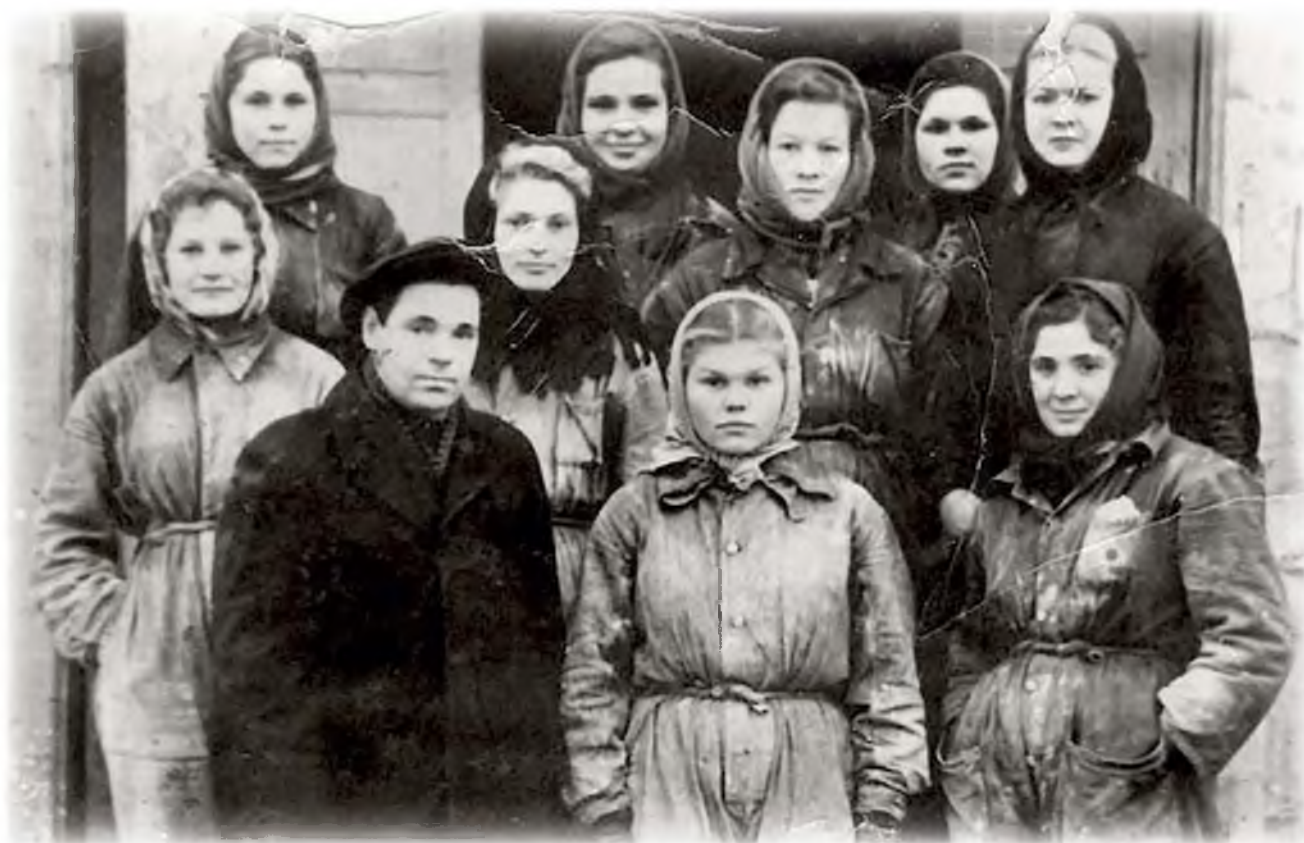
Штукатуры-маляры. 14-ХІ-56 г.
