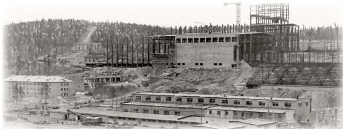
Строительство 1 очереди ГОКа
