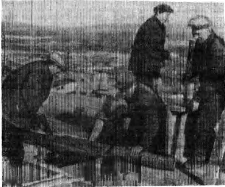
КОВДОР. Плотники из бригады Михайлова Н. А., занятые на строительстве корпуса сушки обогатительной фабрики.
