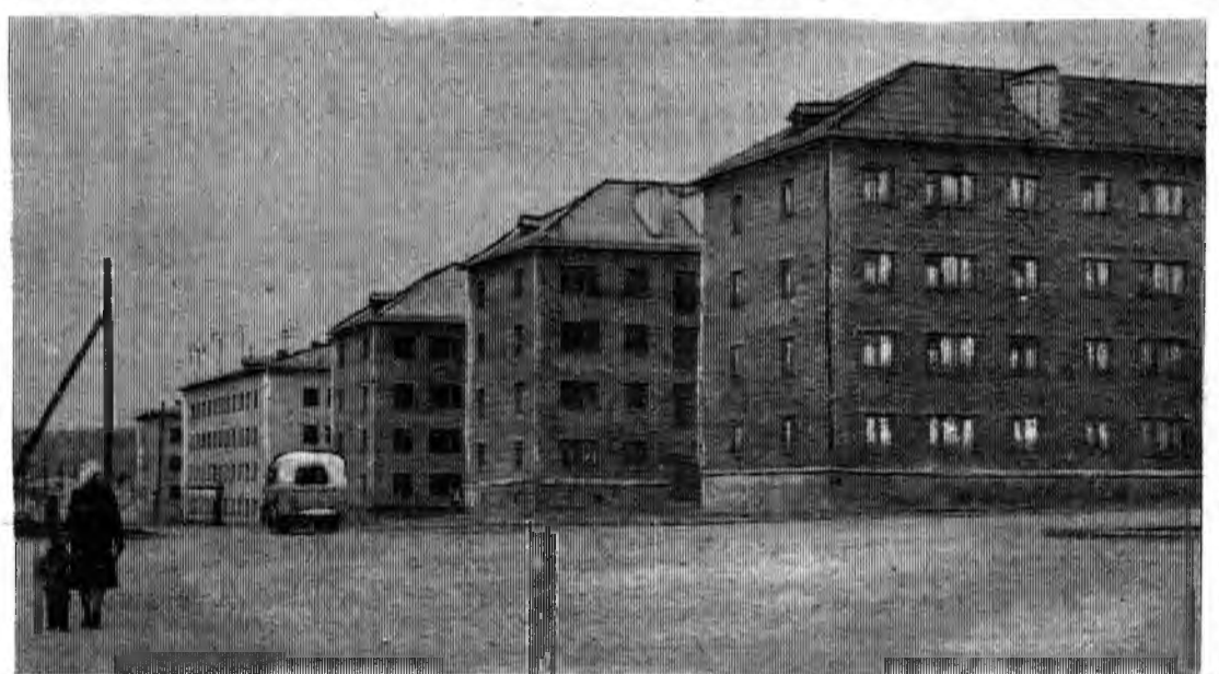
Ковдор. Новыми домами пополняется жилой фонд поселка. Недавно десятки семей справили новоселье. Строители участка «Жилстрой» треста «Ковдорстрой» сдали по улице Кирова два новых 32-квартирных дома. На снимке: новые дома по улице Кирова.
