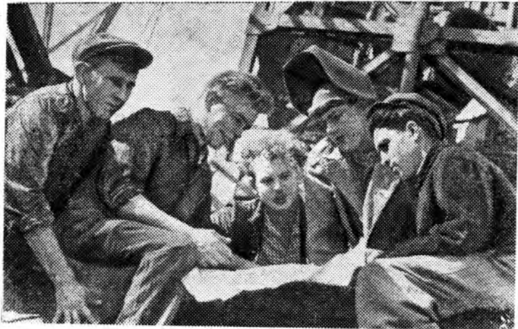
АЗЕРБАЙДЖАНСКАЯ ССР. Коллектив Всесоюзной ударной комсомольской стройки Али-Байрамлинской ГРЭС успешно справляется со своим обязательством по сооружению 4-го энергоблока. Строители обещали сдать его в эксплуатацию в декабре этого года.
