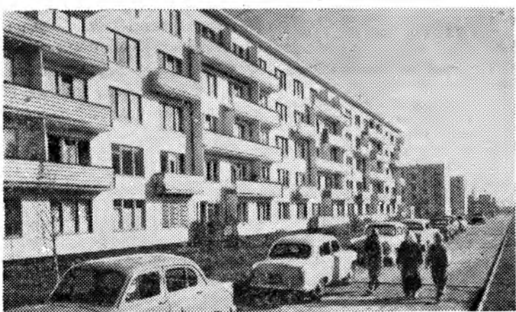
МОСКВА. Этот красивый пятиэтажный жилой дом построен в 10-м экспериментальном квартале Новых Черемушек. Особенность этого здания в том, что оно смонтировано из отдельных блок-комнат заводского изготовления.
