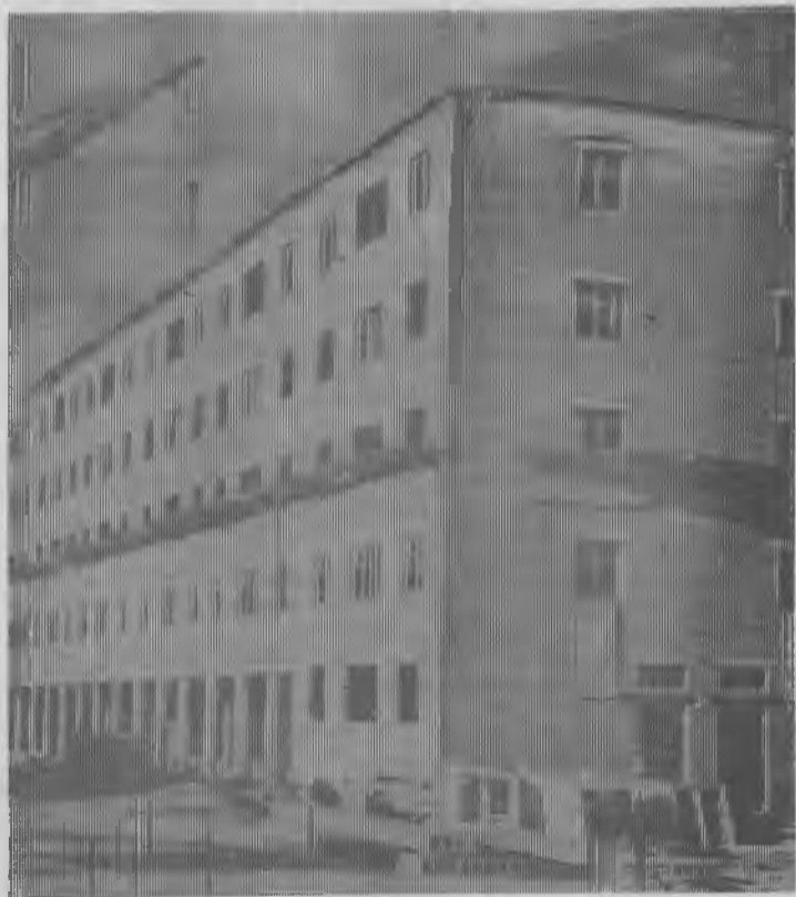
КОВДОР. В 8 квартале заканчиваются монтажные работы на доме № 1, начаты отделочные работы. В нижнем этаже этого дома разместится промтоварный магазин. Это и запечатлел на снимке фотограф.
