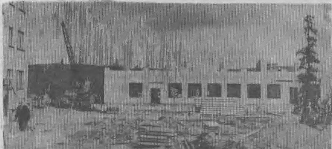
КОВДОР. Трест «Ковдорстрой» начал строительство межшкольных учебно-производственных мастерских на 72 места. Строительство их будет окончено в 1966 году. На снимке: ведется кладка стен этого здания. Фото А. Воробьева.
