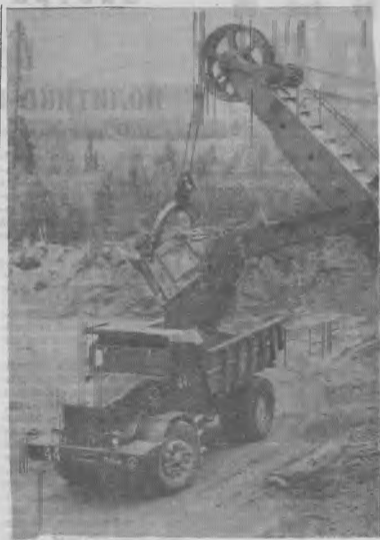
КОВДОР. Рудник Железный. На снимке: работа экскаватора емкостью ковша 4,6 кубометра во вскрышном забое. Грузится морена на самосвал МАЗ-525.
