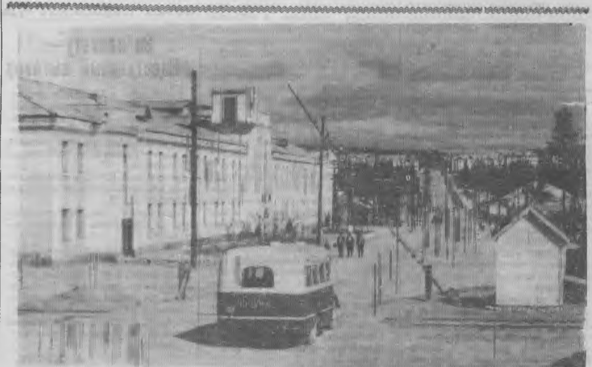
КОВДОР. На снимке: на переднем плане здание дирекции горнообогатительного комбината. Вдали — рабочий поселок. Фото Ф. Антонова.
