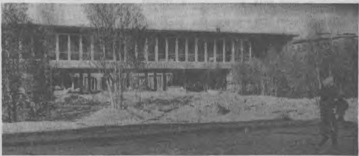
КОВДОР. Строительство Дома культуры на улице Победы.
