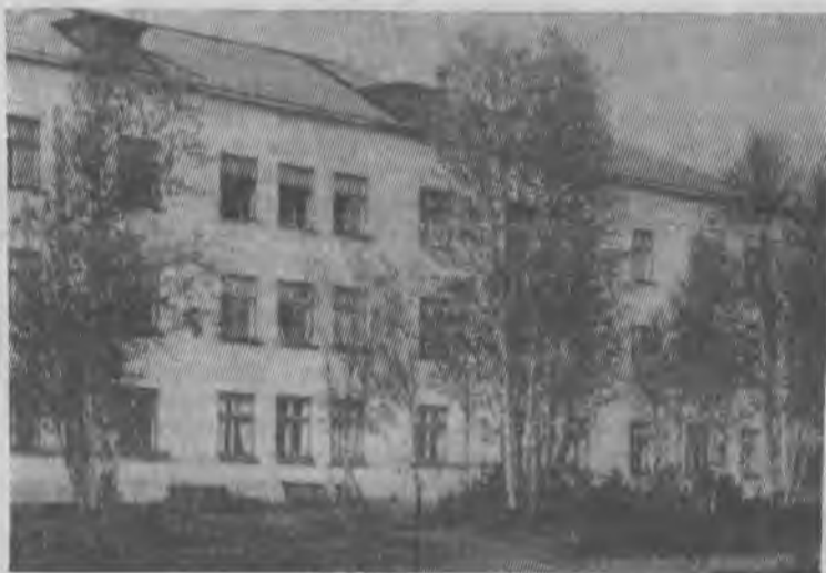
Главный корпус Ковдорской больницы.
