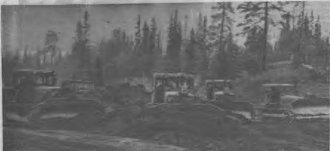
Более 4 тысяч кубометров грунта убрано на строительстве спортивного комплекса. На этой работе было занято 6 бульдозеров. Фото Ю. Петрухина.
