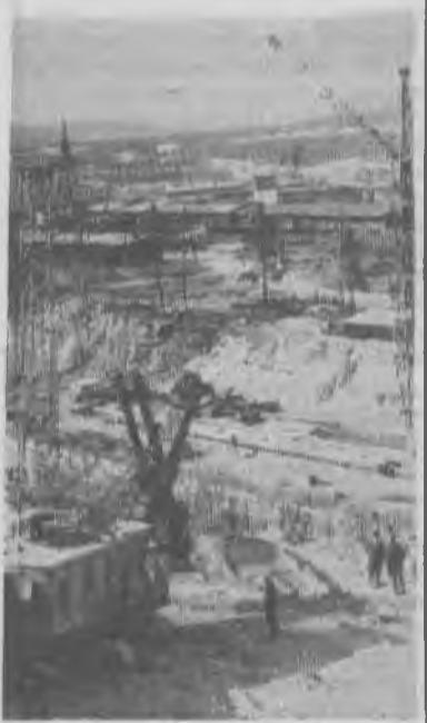
Сегодня на строительстве апатитово-бадделеитовой фабрики. Фото бойца студенческого отряда «Лотос» И. Юдина.
