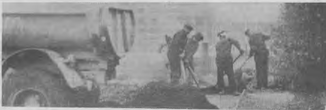
На снимке: Укладка асфальта на улице Кошица. Здесь ведет работы трест «Ковдорстрой» — единственная пока организация в городе, которая откликнулась на призыв Ковдорского ГОКа участвовать в благоустройстве Ковдора. Фото Е. Кругликова, бойца студенческого строительного отряда «Лотос».
