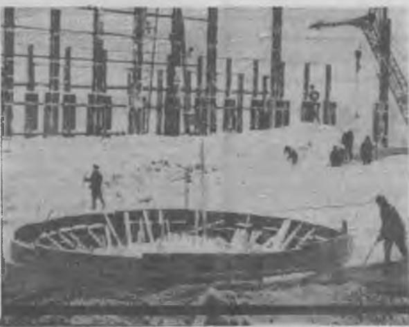
С каждым днем растут вверх и вширь контуры корпусов апатито-бадделейтовой фабрики. На снимке — производство бетонных работ в подземной части корпуса сгущения. На переднем плане — чаша сгустителя. Работы ведет бригада **А. Ф. Даричева**.
