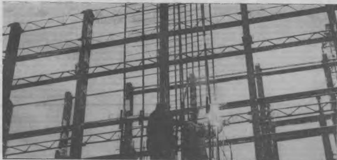
На снимке: момент сварки металлических колонн в электропролете корпуса обогащения апатито-бадделеевой фабрики. Фото Ю. Петрухина.
