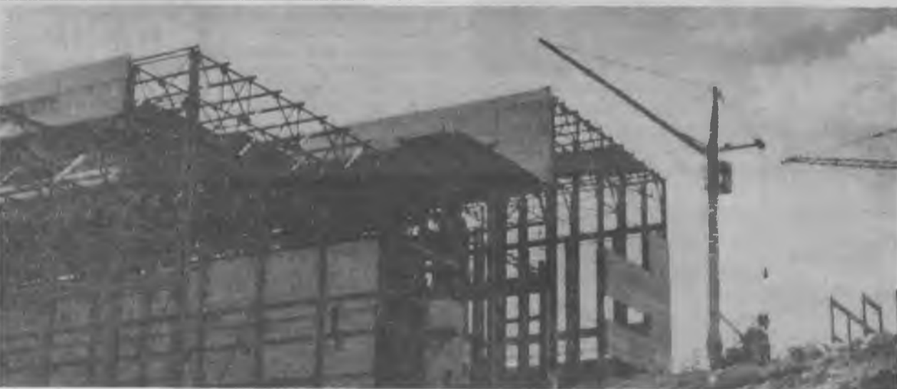
Корпус обогащения. Участку «Севзапстальконструкции» осталось закончить монтаж металлических покрытий пролетов «А» — «Б» и «Е» — «Д». Бригада П. Корнюха бетонирует 3-е монолитное перекрытие и монтирует стены третьего этажа энергопролета. Комсомольско-молодежная бригада А. Дробота в пролетах «А» — «Б» и «Б» — «В» навешивает стеновые панели. На снимке: Пролеты от ряда «А» (справа) до ряда «Е».
