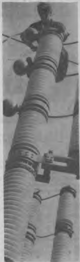
На самой верхней точке будущей высоковольтной подстанции АВОФ. Фото Г. Антонова.
