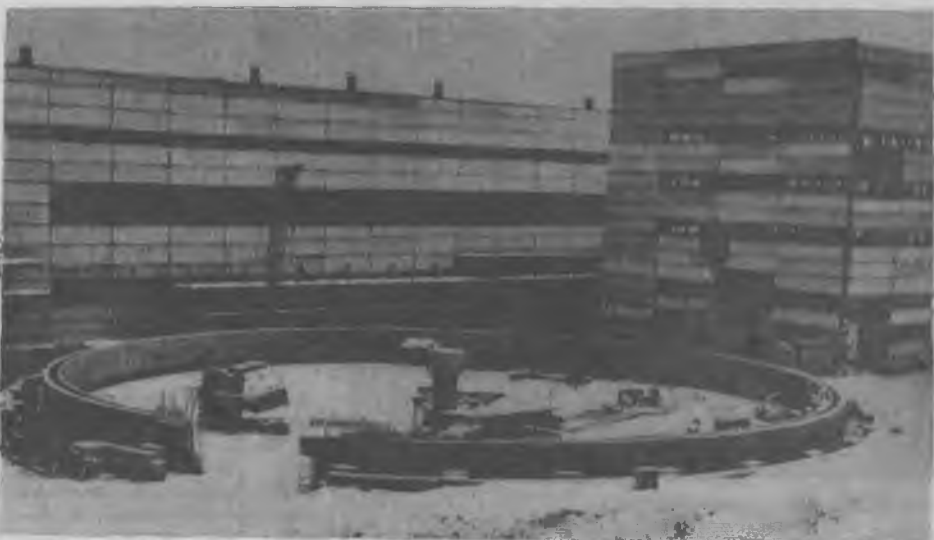
На чаше сгущения уже приступили к установке оборудования монтажники Заполярного управления «Металлургпрокатмонтажа». Параллельно с ними монтирует металлоконструкции чаши бригада кавалера ордена Ленина Михаила Муратова. После этого в работу включатся строители «Промстроя-1» во главе с А. Ф. Даричевым.
