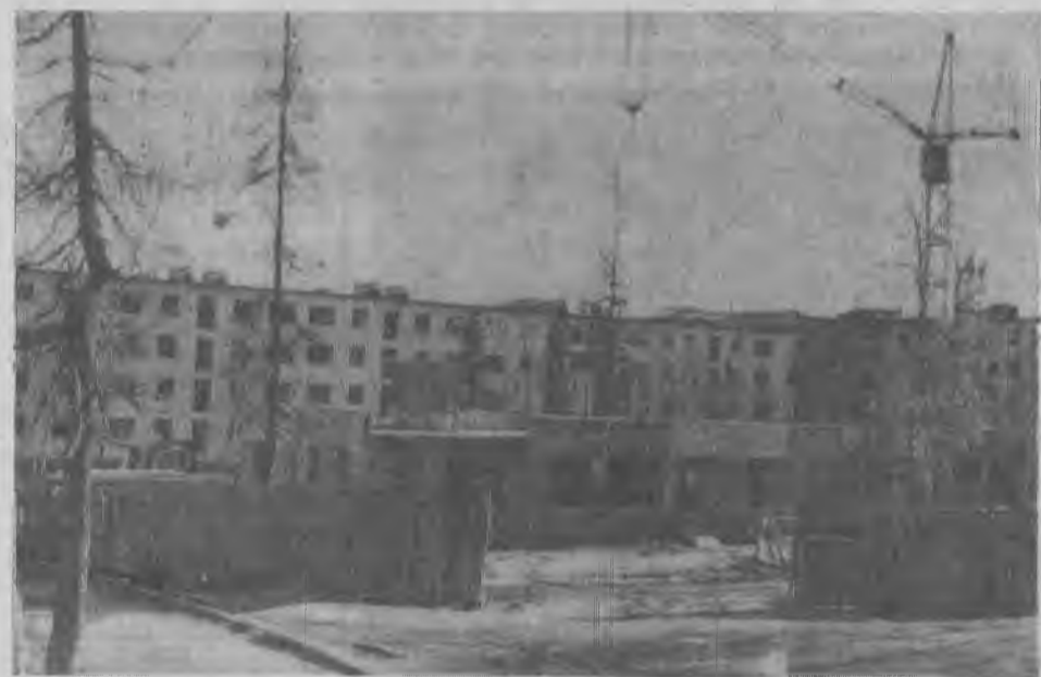
Начато строительство детского садика на 140 мест по улице Зеленой для детей работников треста «Ковдорстрой».
