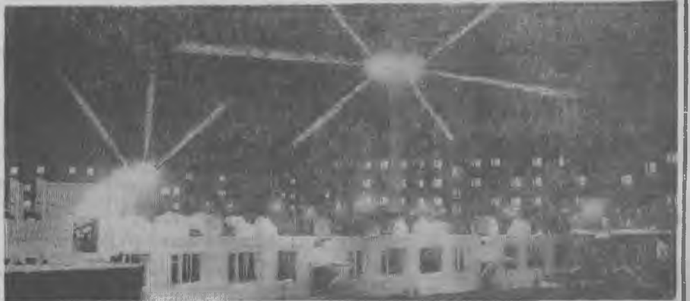
Растет новый 120-квартирный дом в Микрорайоне.
