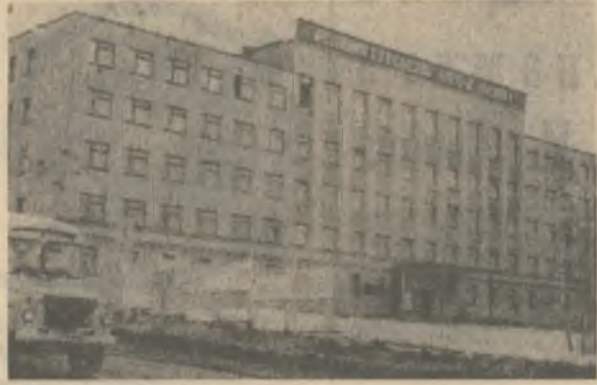
Здание управления Ковдорского ГОКа.
