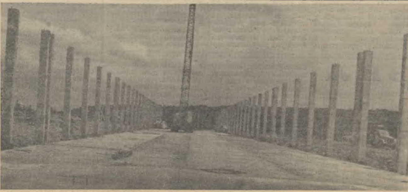
С расширением карьера рудника «Железный» в его зону попадают производственные помещения вспомогательных служб, склады оборудования, материалов и т. д. У ручья Можель начато строительство базы ма-
