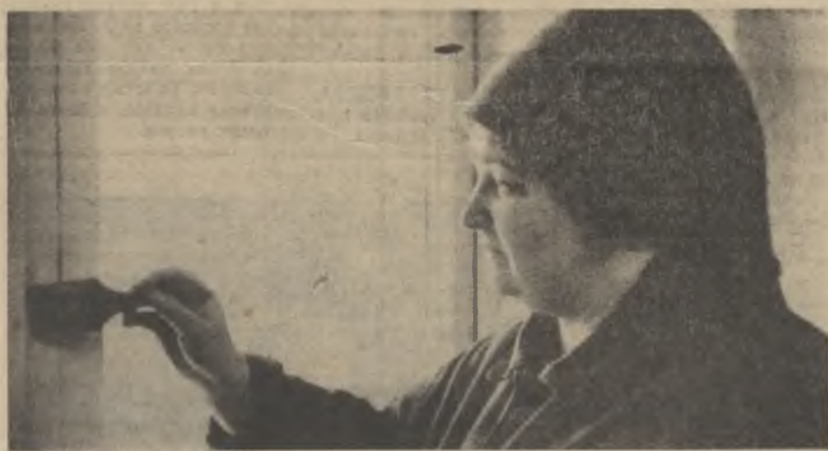
На обогатительном комплексе косметическим ремонтом занимается ремонтно-строительная группа. Штукатур-маляр Анна Александровна Бушенева — одна из лучших работниц этой группы. Она ударник коммунистического труда, неоднократно поощрялась Почетными грамотами, благодарностями. И не только за хорошие производственные показатели. Анна Александровна еще и активный участник художественной самодеятельности. Песня — нередкий спутник ее в труде. Фото Ю. Петрухина.
