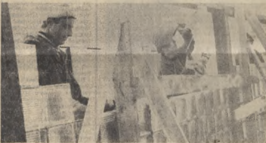
Сварка металлических каркасов, заполнение их стеклблоками, покраска — все это делается на земле. Потом один подъем краном — и оконный проем 9-й секции полностью закрыт. Удобно и быстро.
