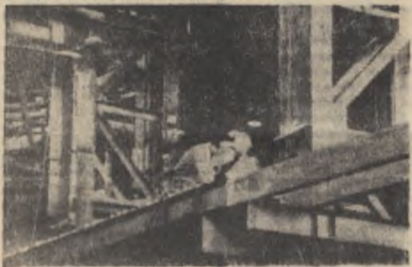
Сварка металлических каркасов, заполнение их стеклблоками, покраска — все это делается на земле. Потом один подъем краном — и оконный проем 9-й секции полностью закрыт. Удобно и быстро.
