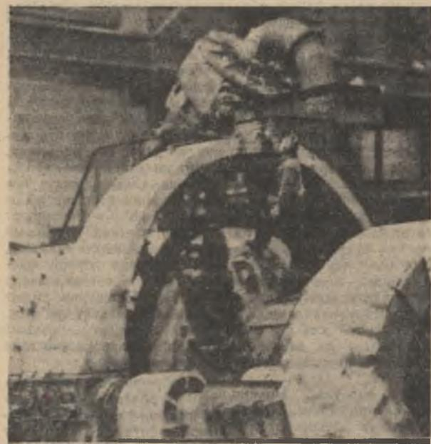
Бригада слесарей-монтажников И. Доценко из Металлургпрокатмонтажа» обтягивала болты шаровой мельницы. Сегодня будет все готово для прокрутки шаровой мельницы.
