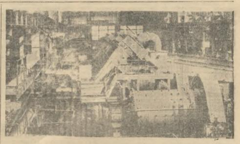
В рабочем строю. Первая и вторая секции участка обогащения МОФ после реконструкции будут выпускать в год 1.600 тысяч тони железного концентрата. Как известно, первая секция вступила в строй досрочно — ко Дню строителя. В конце декабря поставлена под промышленную нагрузку и вторая секция. На 0 часов 26 лекабря она переработала 12.255 тони руды и выдала 4.530 тони железного концентрата.
