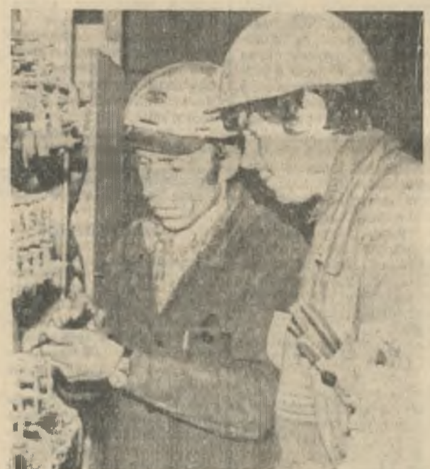
Хорошо потрудились на реконструкции первой секции МОФ электромонтажники участка «Севзапэлектромонтаж». В сложных условиях бригада Михаила Ивановича Панина сумела обеспечить своевременную сдачу в эксплуатацию оборудования участка обогащения. На снимке: бригадир М. И. Панин и электромонтажник А. Калинин.
