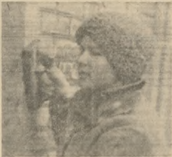
На снимке: группкомсорг бригады Татьяна Громова. Фото Л. Крепцовой, штукатур-маляра бригады Л. Л. Смеловой из СУ-4.
