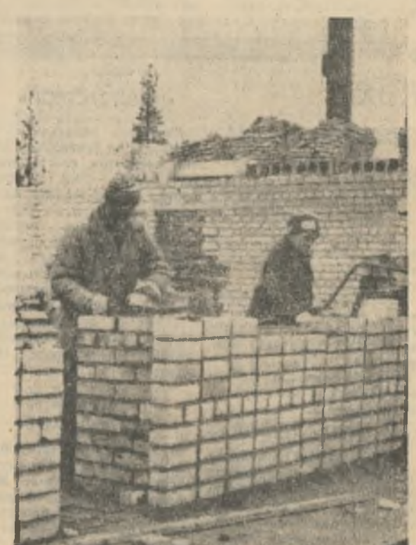
Жилой дом в поселке Лейни строит подрядная бригада каменщиков Ю. Ф. Зарубина из СМУ-3. Фото Ю. Петрухина.
