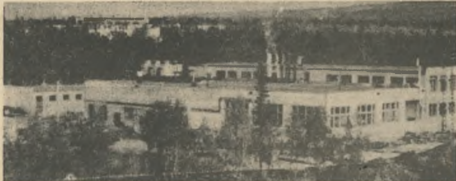
Общий вид здания молокозавода.
