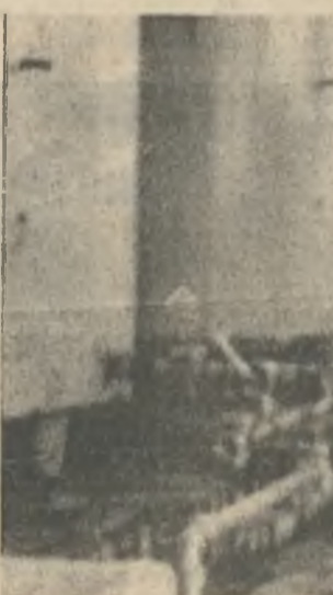
На снимке: идет монтаж трубопровода для транспортировки молочной продукции.
