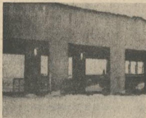
Контрольно-пусковой пункт БелАЗов на площадке цеха технологического транспорта — один из объектов пускового комплекса. Фото О. Вишневецкой.
