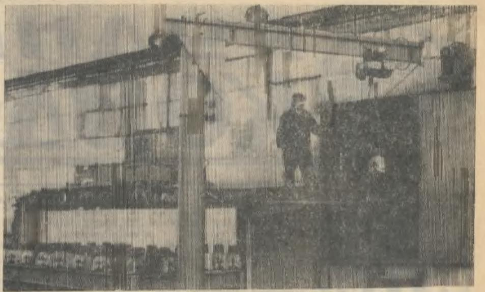
Даже меньшее долото из двух видов, что идут к буровым станкам СБШ-250МН, гораздо тяжелее двухпудовой гири. Попробуй-ка, поворочай такими снарядами — руки отвалятся. Поэтому на помощь рабочим пришел кран-укосина — для механизации погрузки и разгрузки шарошечных долот, когда, скажем, их необходимо направить на реставрацию в механические мастерские. Это — быстрота, удобство, безопасность.
