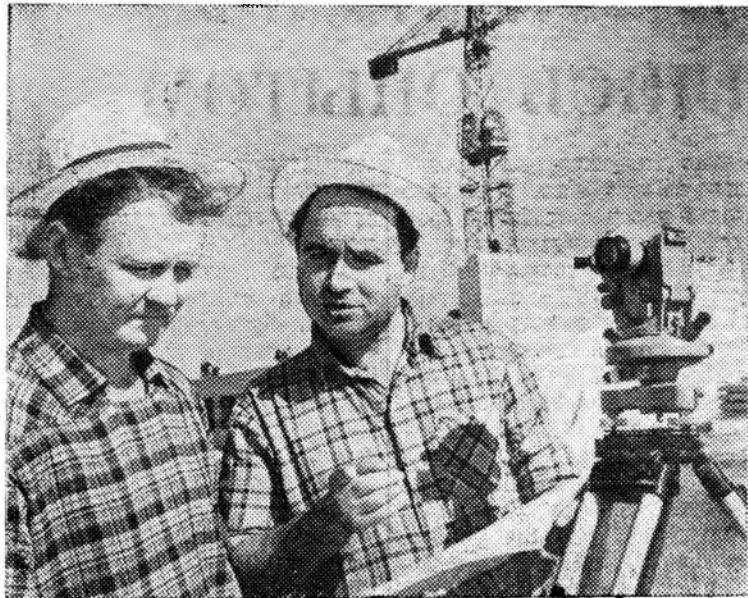
Белорусская ССР. На окраине Гомеля началось строительство суперфосфатного завода. Этот гигант химической промышленности к концу семилетки должен выдать первую продукцию.
